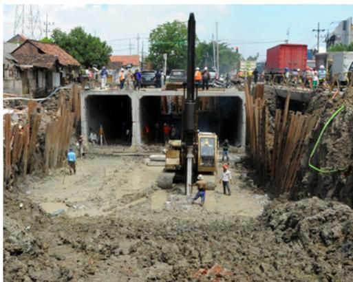
**Gambar 10. Pembangunan *Box Culvert***
